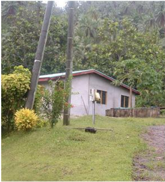
Habitation moderne , murs en béton et toit de tôle
