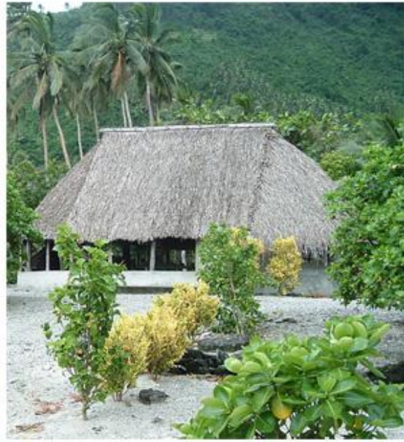
Habitation traditionnelle polynésienne , le falé : toit en feuille de pandanus, avec ou sans mur de béton
